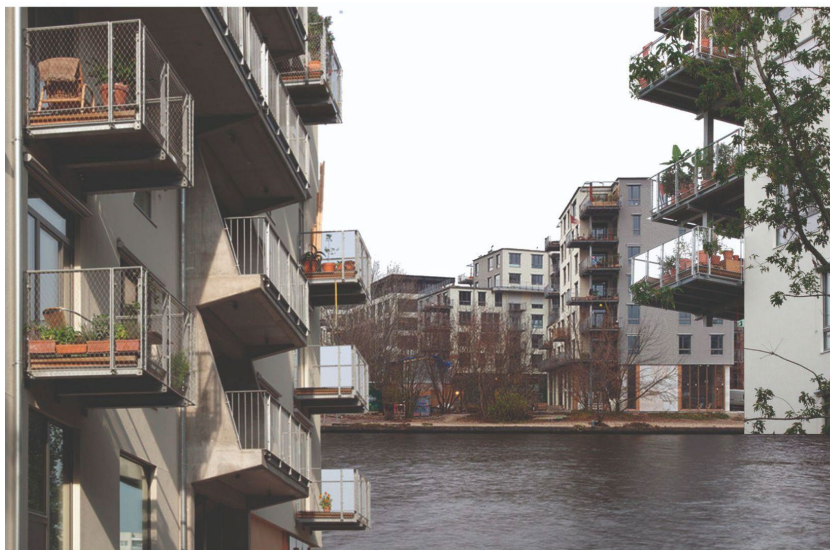
Figura 3. Collage analítico de elaboración propia del proyecto Spreefeld Cooperativa de Vivienda sobre el río Spree (Carpaneto Architekten, Fatkoehl Architekten y BARarchitekten, 2014). Imágenes utilizadas provenientes de ArchDaily.
