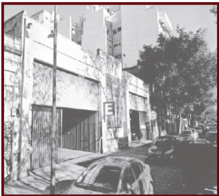
_ lote 6 DIRECCIÓN: Acevedo 955 PISADA: 1.360 m 2 ALTURA MAX.:14,6 m UTILIDAD ACTUAL: Estacionamiento
