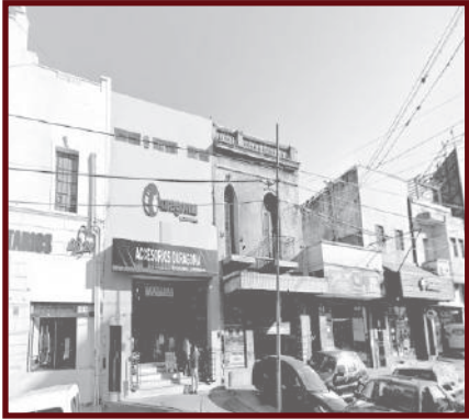
_ lote 5 DIRECCIÓN: Warnes 914 PISADA:4.350m 2 ALTURA MAX.: 22,8 m UTILIDAD ACTUAL: Viviendas y locales
