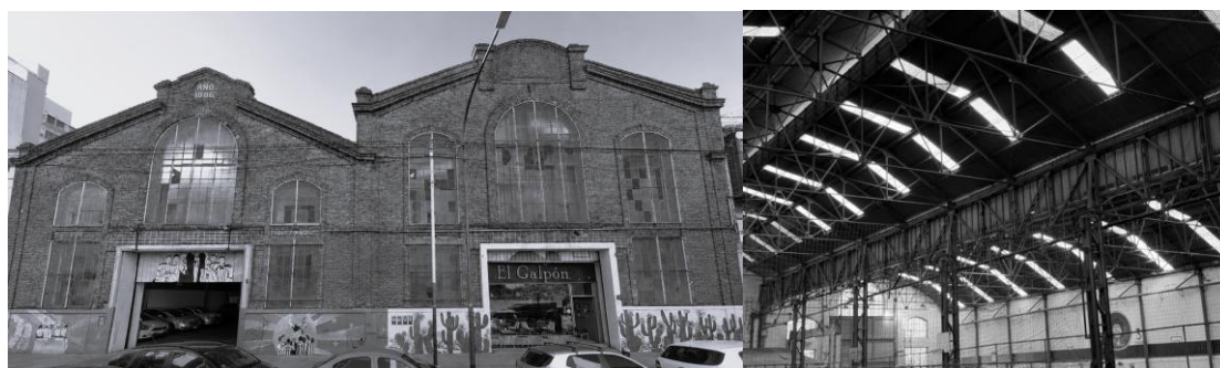
Figura 14. La preexistencia industrial sobre la que se implanta el polo. Izquierda: los dos galpones metalúrgicos contiguos, contruidos en 1886 y unificados por una fachada de ladrillo común con frontones y grandes ventanales en arco, constituyen el plano histórico que el proyecto conserva íntegro como umbral material entre el barrio y el conjunto. Derecha: el interior de una de las naves, donde las cerchas metálicas —conservadas en su tonalidad de óxido original— sostienen la cubierta de chapa que el proyecto retira para dejarlas expuestas como pórticos exentos. Lo que era techo se vuelve pórtico; lo que era interior se vuelve exterior. Elaboración propia (TFC, 2025)
