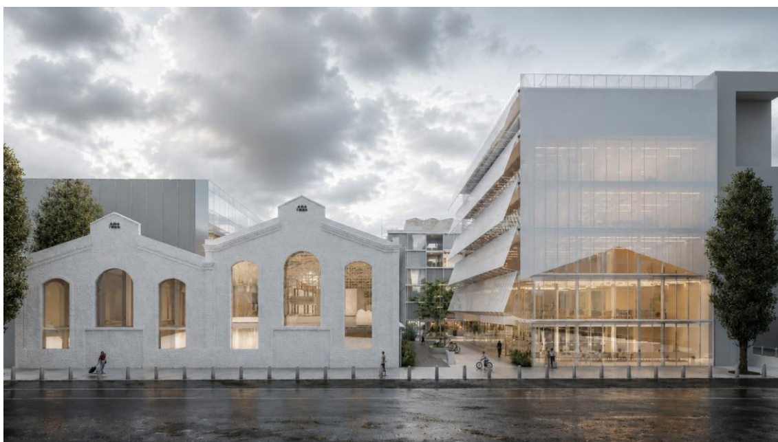
Figura 15. Vista del frente urbano del polo turístico-cultural. La fachada de 1886 se conserva íntegra en su fábrica y su geometría —frontones, ventanales en arco, aparejo de ladrillo— y se blanquea para incorporarse al sistema cromático
