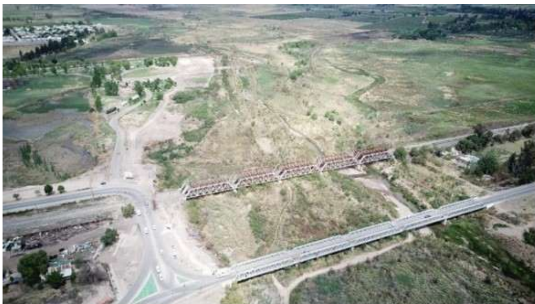
Figura 13: Acceso Vial y Ferroviario.
