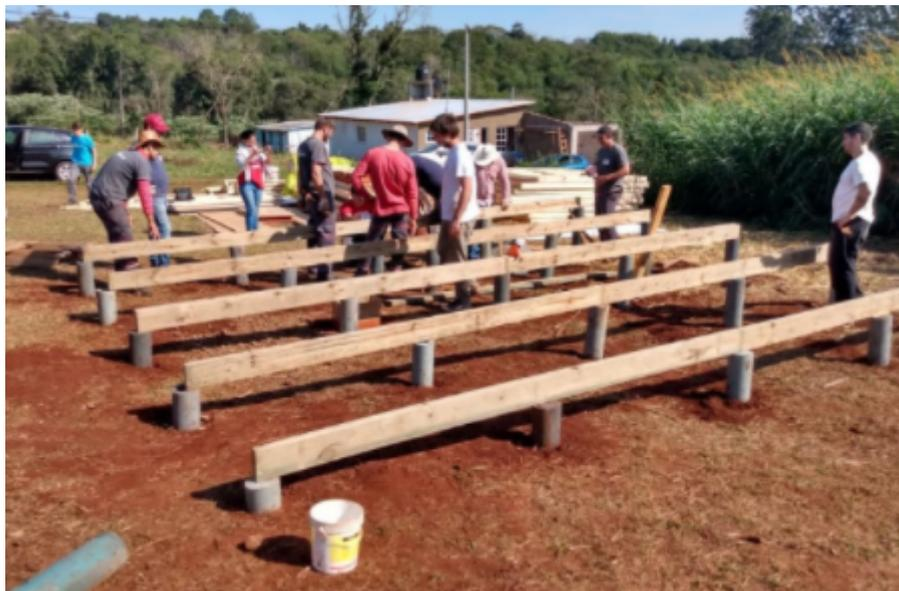
**Imagen 4.5 – Vigas de piso para modelo de vivienda compuesto por 4 módulos**
