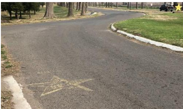
Figura 2.7 Fuente: Elaboración propia. Foto carril 1
