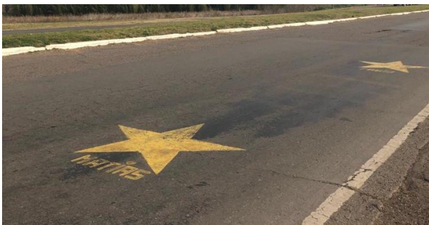
Figura 2.5 Fuente: Elaboración propia. Foto carril 2.
