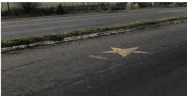
Figura 2.6 Fuente: Elaboración propia. Foto carril 5.
