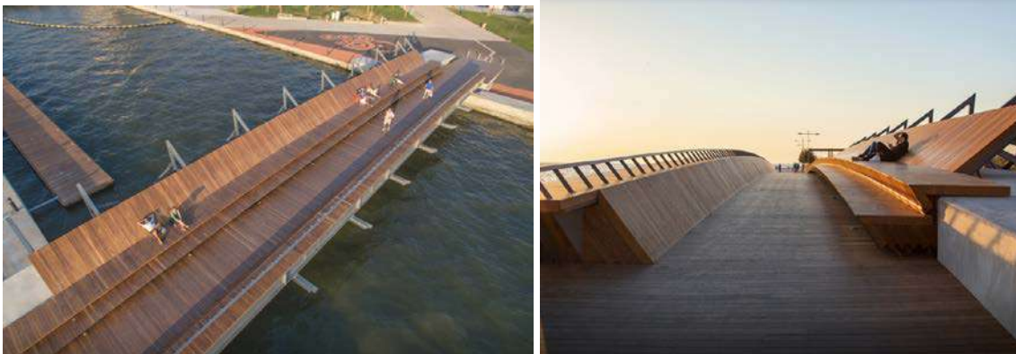
Imágenes del puente costero. Bostanli, Turquia.
