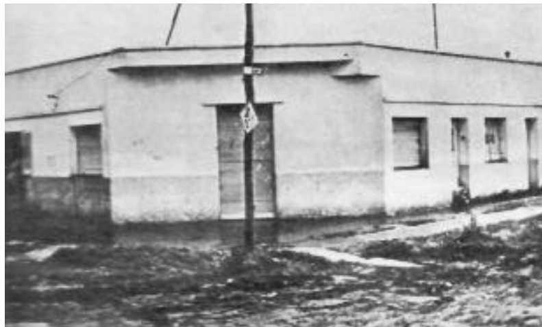
La casa del secuestro. En la parte de arriba funcionaba una vieja mercería. La celda tenía 2 metros por 1 y estaba debajo de un patio interior ( Gente )
