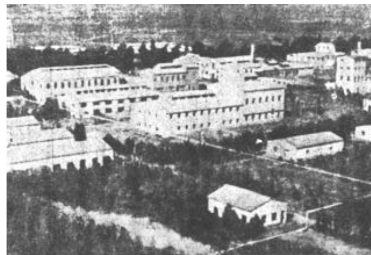
Algunas de las instalaciones de la Fábrica Militar de Pólvora y Explosivos, que fue copada por un comando extremista
