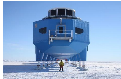
Figura 3.2: Estación Halley VI
