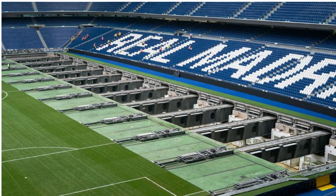
Imagen 10: Funcionamiento del campo retráctil.
