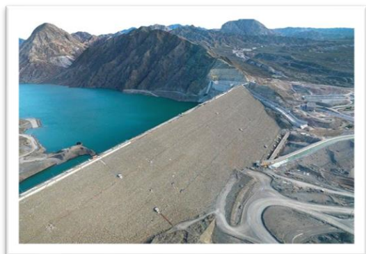
Foto completa de la Presa
