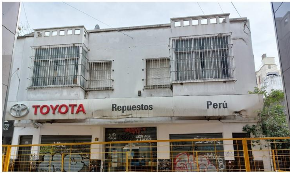
Fig. 124. Edificio Rawson. Estado de Israel 4201 esq. Palestina (Ex- Rawson) - C.A.B.A.. Fuente: Ficha: Carolina Quiroga - Foto: Carolina Quiroga
