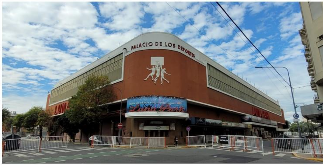
Fig. 110. Casa de renta. Av. Santa Fe 3546 - C.A.B.A. Fuente: Ficha: Alan C. Jones - Foto: Stella M. Casal
