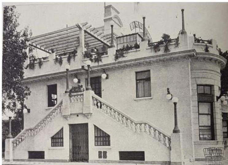
Fig. 75. Cervecería "Don Juan de Garay". Av. Dr. Tristán Achával Rodríguez 1353 - C.A.B.A. Fuente: Ficha: Fernando Couturier - Foto: Revista del Centro de arquitectos, Constructores de obras y Anexos, (35)
