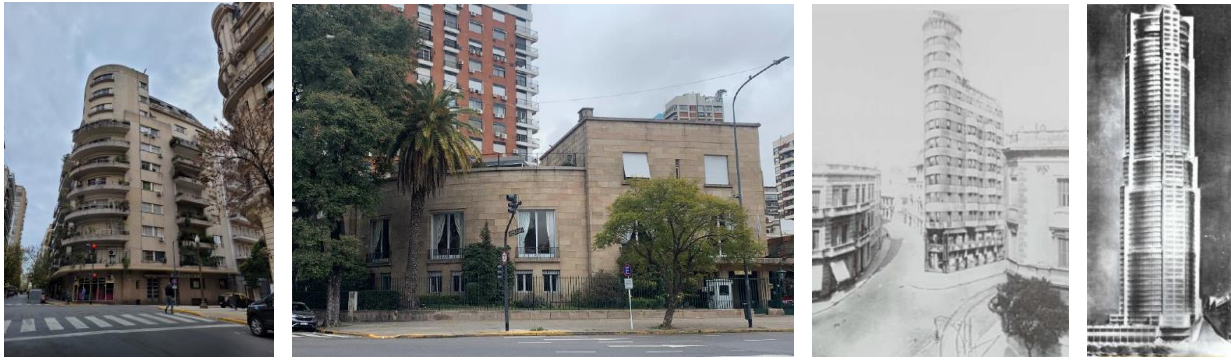
Fig. 20. Edificio Minner (C.A.B.A). Fuente: foto: Fernando Couturier
